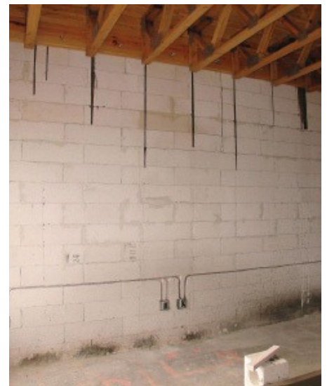
Fig. 27: Electrical conduits in Hebel® Wall.
